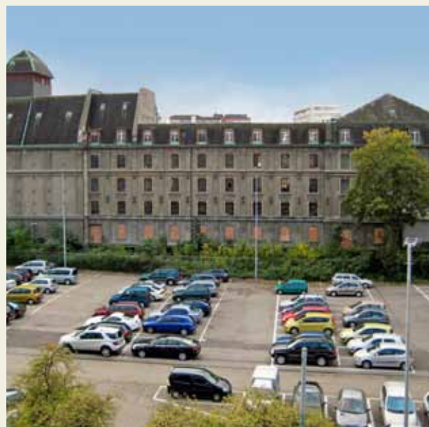
So sieht das Gelände der Aktienmühle heute aus.
